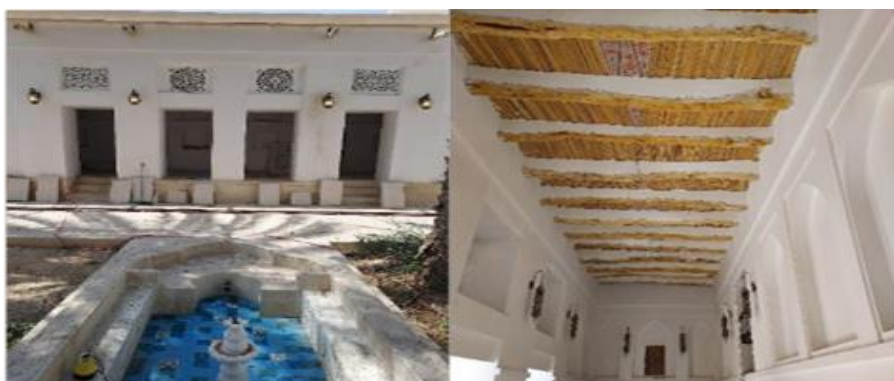
شکل ۲. نمایی از معماری فضاهای بومی شهر گراش
